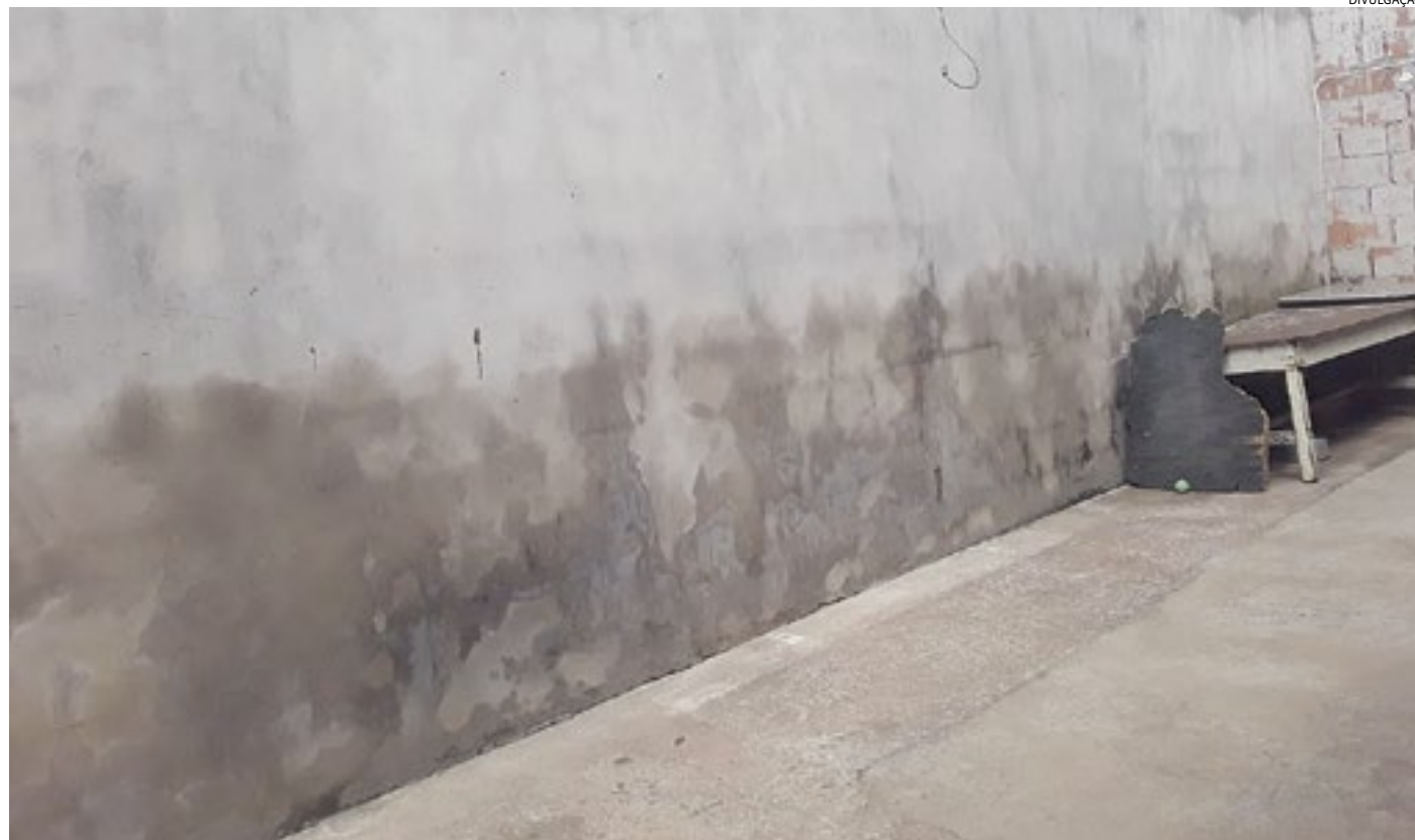
Depois de muitas reclamações sem soluções, o muro caiu, já que estava em péssimas condições e não foi construído de maneira correta
