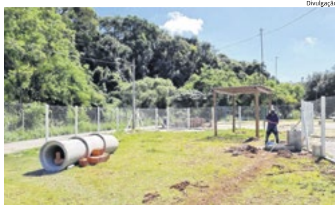
O ParCão está sendo construído em uma área de 500 m 2
