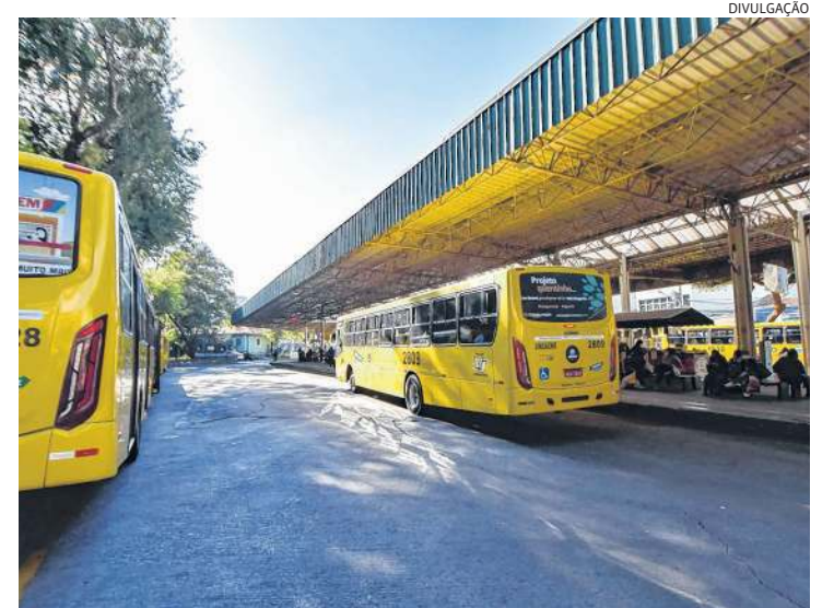
Linhas do Terminal Vila Arens e Terminal Central passam por alterações
