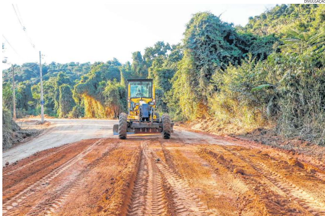
Via Adalberto De La Fuente y Rodrigues liga Itupeva a Indaiatuba e terá pavimentação e sinalização
