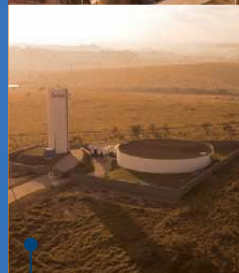
NOVO RESERVATÓRIO FAZGRAN
