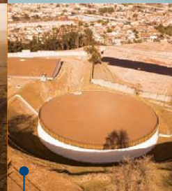
NOVO RESERVATÓRIO JARDIM CARLOS GOMES
