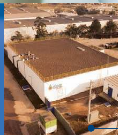
NOVO RESERVATÓRIO DISTRITO INDUSTRIAL
